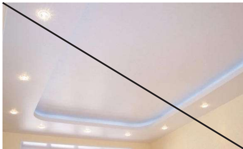
Плохо Многоуровневые гипсокартонные конструкции
