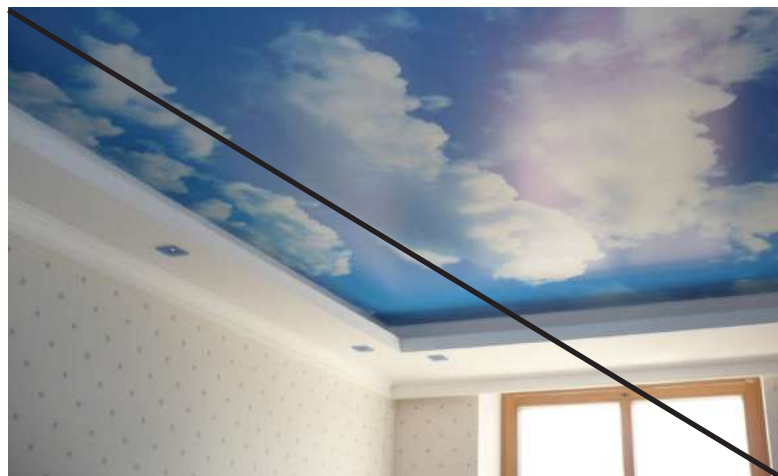
Плохо Натяжные потолки. Потолки с рисунками
